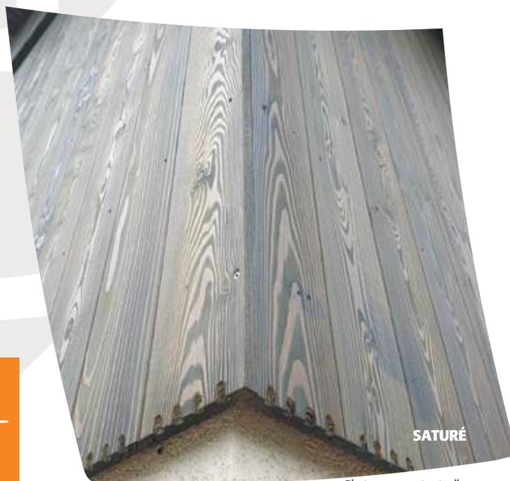
Héritiers d'un savoir-faire ancestral, nous veillons lors de la fabrication à l'orientation du cœur du bois. Orienter le cœur au soleil avantagera la déformation prévisible des pièces de bois pour que le bois bombe plutôt que ne creuse. Pour un platelage cloué si les cœurs font face au sol, les planches creuseront en soulevant les extrémités ainsi que les clous. Les fibres du bois proches du cœur sont plus solides que vers l'extérieur (dosse).
